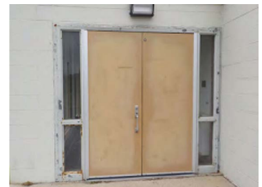
Society Bldg Door and Frame
